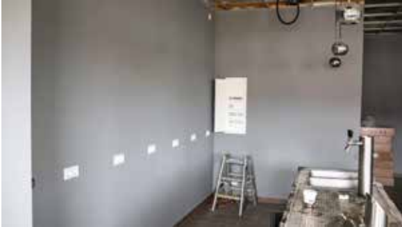
Hier sind die Vorkehrungen für die Bar, die noch gebaut werden muss, getroffen. Auch der Durchbruch für die Bierzapfanlage muss noch hergestellt werden.
