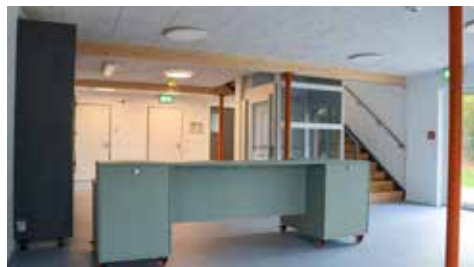
Links: Obergeschoss, Treppe und Fahrstuhl
